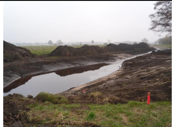
Während der Umbaumaßnahmen im März 2014 (© Logemann).
