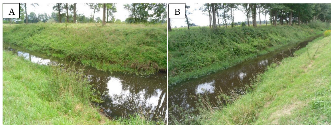
Abb. 52: Der Vechtaer Moorbach an der Probenstelle 9. A: Bachaufwärts unmittelbar nach dem Einfluss der Kläranlage (© Logemann). B: Bachabwärts, jeweils im August 2014 (© Logemann).
