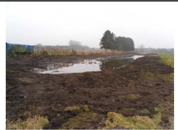
Während der Umbaumaßnahmen im März 2014 (© Logemann).
