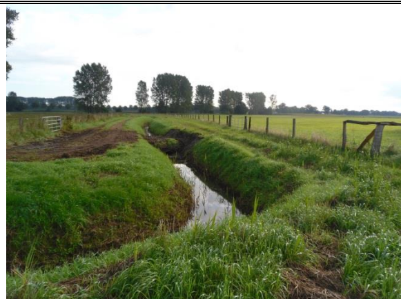
Vor den Umbaumaßnahmen im August 2013 (© Logemann).
