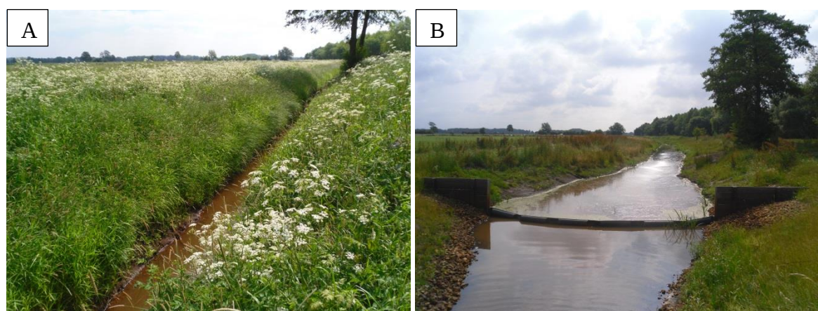
Abb. 41: Ein Zulauf des Vechtaer Moorbachs mit der Probenstelle B: A: Vor dem Umbau im Juni 2013 (© Logemann). B: Nach dem Umbau im Juli 2015 (© Logemann).
