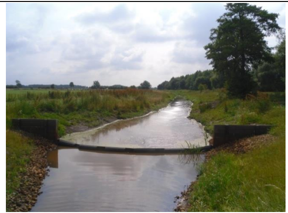
Nach den Umbaumaßnahmen im Juli 2015 (© Logemann).
