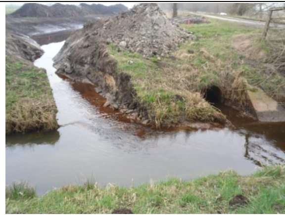
Während der Umbaumaßnahmen im März 2014 (© Logemann).
